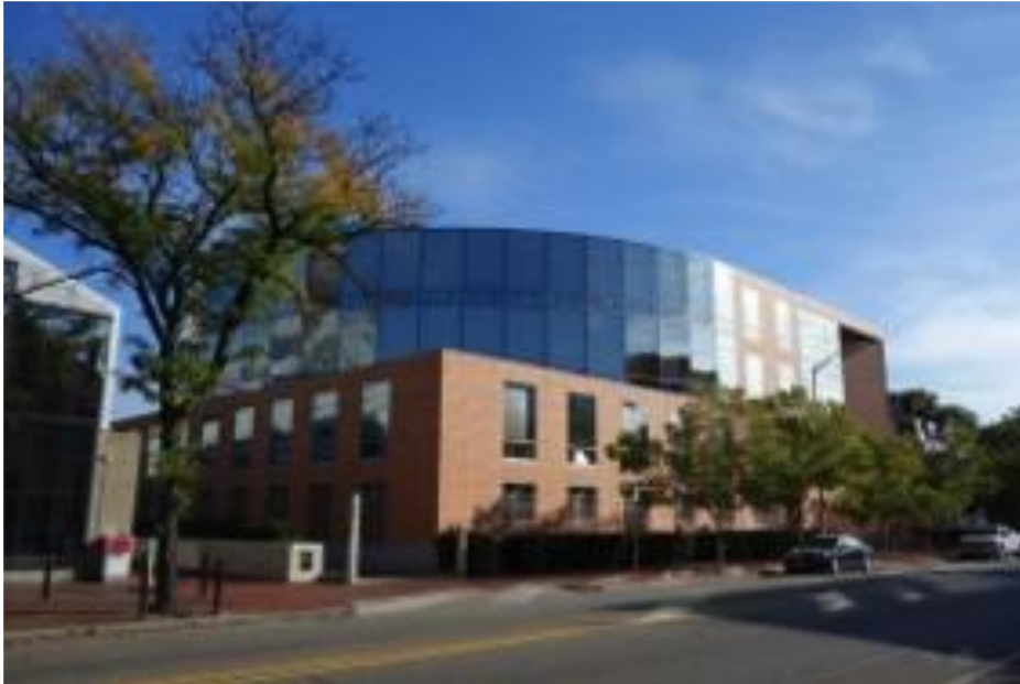
Harvard-MIT DataCenter (HMDC)
